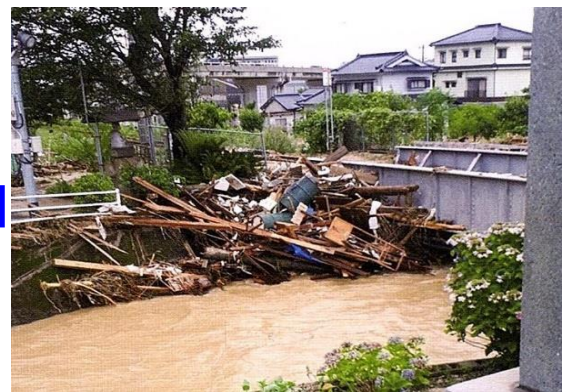
鉄橋に引っ掛かった流木等 (災害時の様子)
