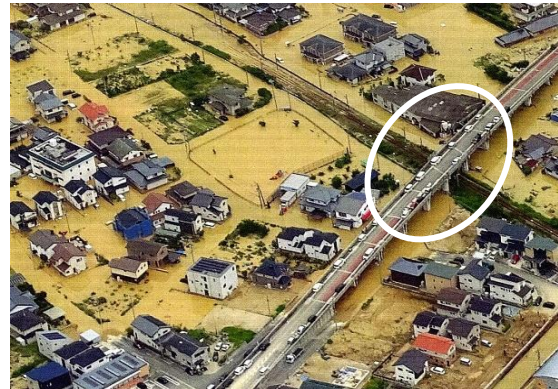
高架橋付近:茶色は浸水部 (災害時の様子)
