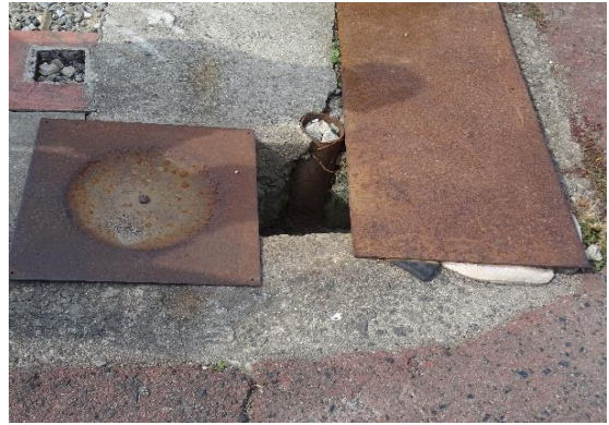
側溝ふたの開口部(今の様子) (災害時は水浸し)
