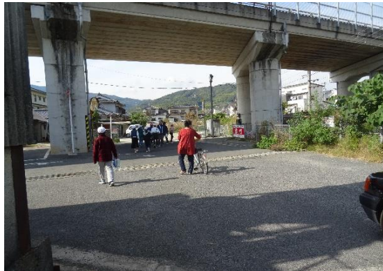
高架橋の下:災害時は水浸し (今の様子)
